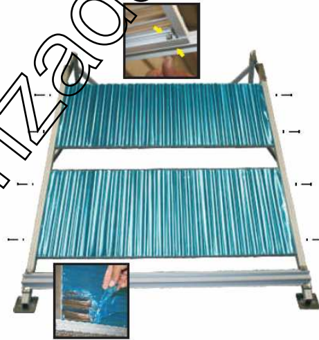
Figura 4 Colocación de reflectores
