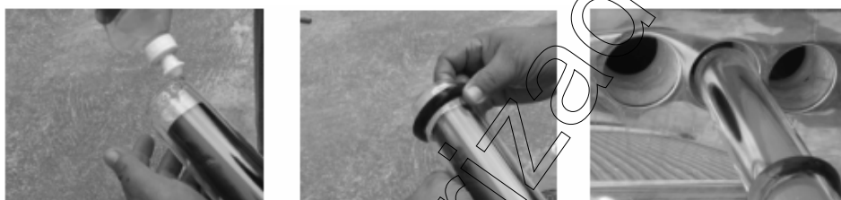
Figura 7 colocación de los tubos de vacío
