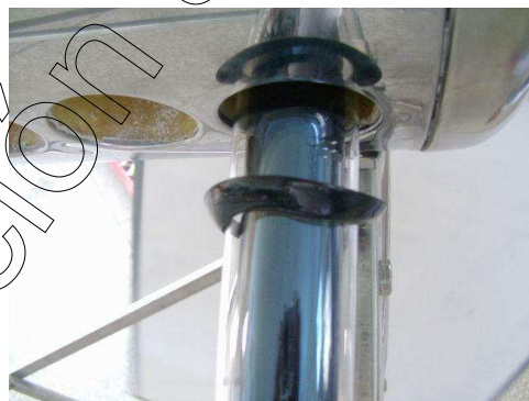
Figura 3 ajuste del tubo de vacío en el soporte inferior
