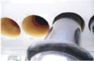
Figura 4 Insertar tubo de vacío en termotanque
