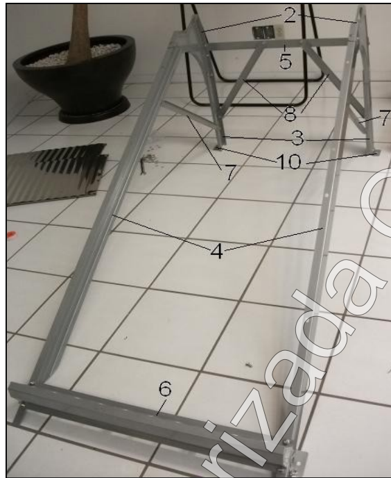
Figura 2 armado de la estructura de soporte
