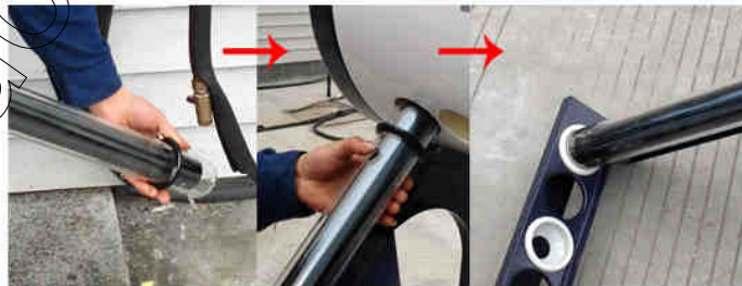
Figura 6 colocación de los tubos de vacío
