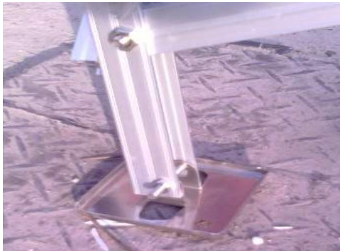
Figura 7 Bases de la estructura de soporte
