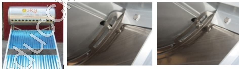
Figura 11 Colocación del termotanque en la estructura de soporte
