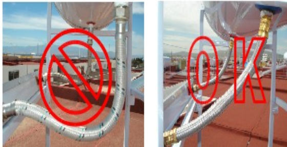
Figura 3 Conexión colector solar con termotanque
