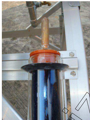
Figura 2 colocación del sello de silicón
