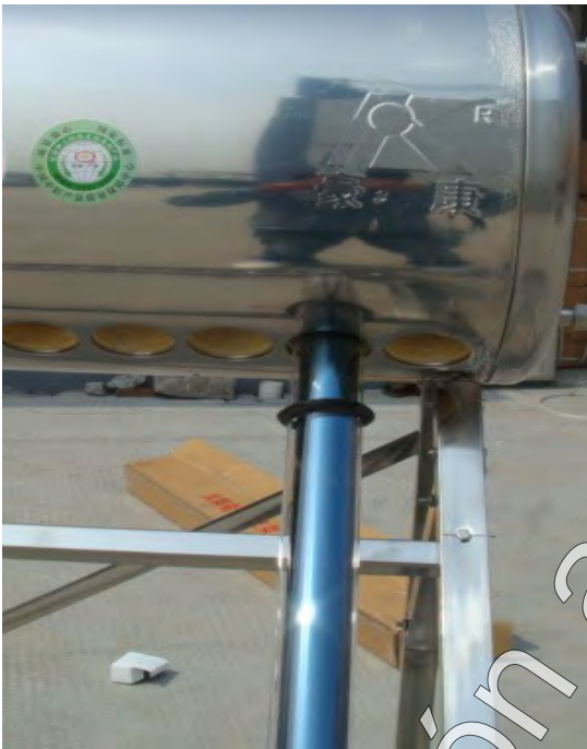
Figura 7 Montaje de tubo de vacío en el termotanque.
