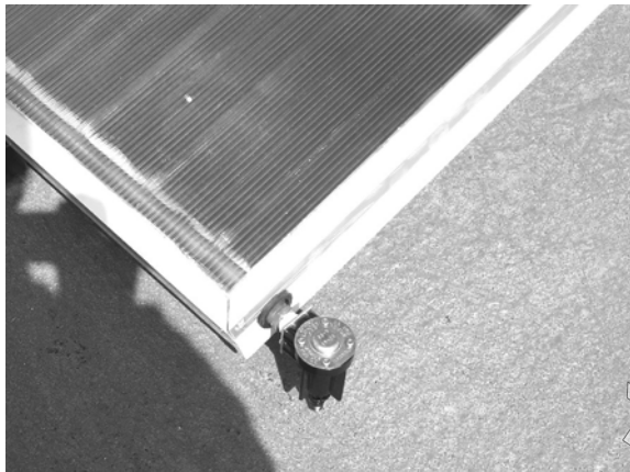
Figura 5 Válvula de protección anticongelante
