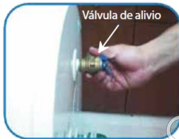
Figura 8 Válvula de alivio
